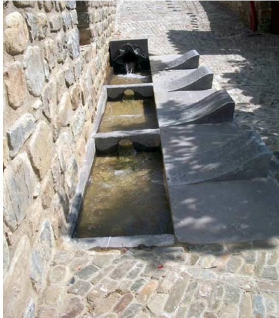
Lavadero municipal recuperado
