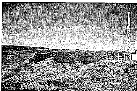
Repetidor en el cerro del Aguilar.
