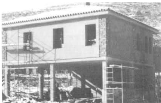
Construcción del Centro Social. Años 80
