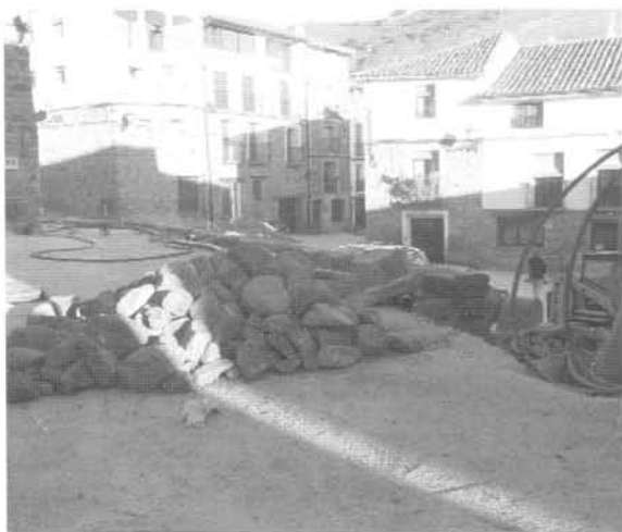
La plaza, en obras
